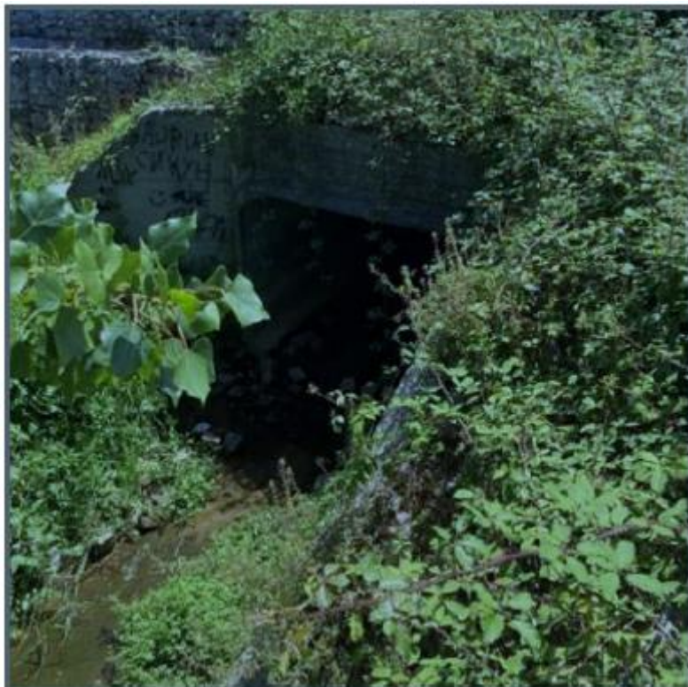
Figura 11 - Passagem Hidráulica em linha de água que será intersetada por um gasoduto
